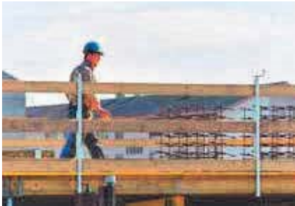
Absturzkante an Deckenschalung (z.B. bei Betonierunterbrüchen)
