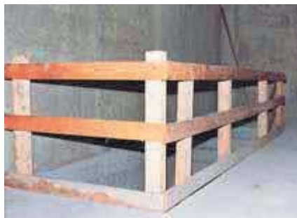
Absturzkante im Rohbau innen (z.B. Treppenöffnungen)
